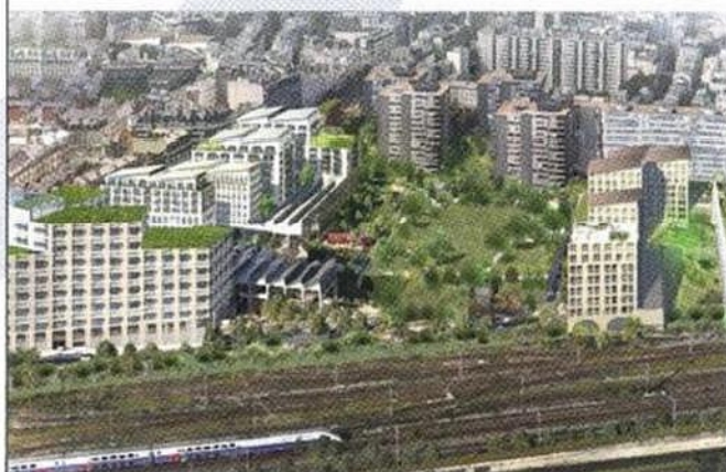
Ordener-Poissonniers, vue aérienne depuis le faisceau ferroviaire Copyright : BiecherArchitectes
